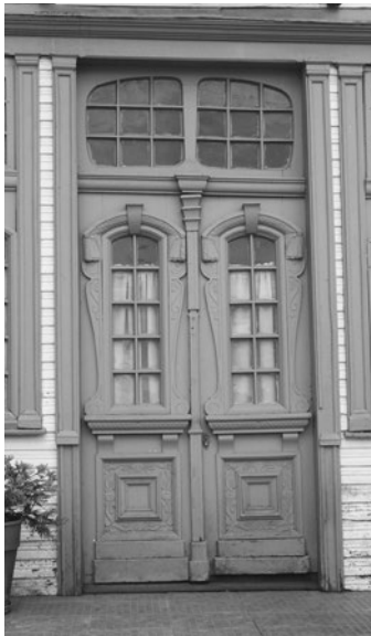
Fig. 223: Puertas vidriadas; vivienda en Purranque. Foto: GCB.
