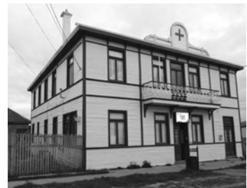
Figs. 217b, c y d: Fierro galvanizado liso; viviendas en Punta Arenas. Fotos: GCB.
