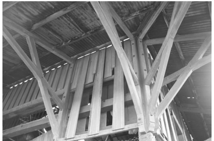
Figs. 143f y g: Bodega ferroviaria de 30m. Estructuras de techumbre y aleros. Dibujo y foto: GCB.
