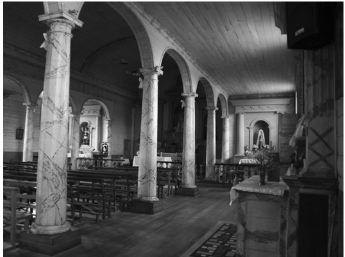
Fig. 164: Columnas huecas de madera con pintura imitación mármol en iglesia de Nercón, Chiloé. 1890 (MN). Foto: GCB.
