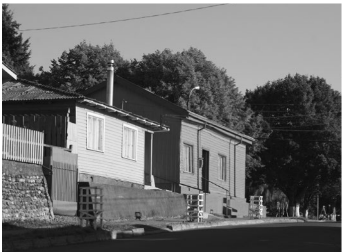
Fig. 53: Zócalos en calle 7° de Línea esq. Orella, Cañete. Foto: GCB.
