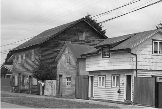
Fig. 45: Continuidad de fachadas; calle Las Heras, Purranque. Foto: GCB.
