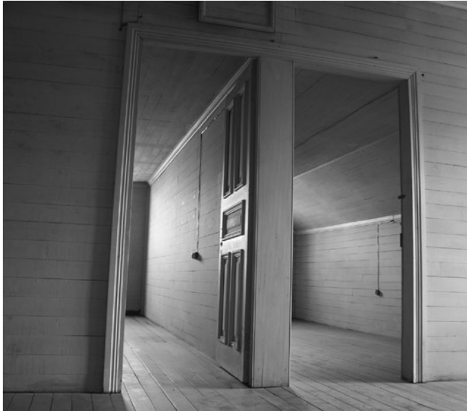
Fig. 220c: Revestimientos interiores en madera; vivienda en Traiguén, Región de La Araucanía. Foto: GCB.
