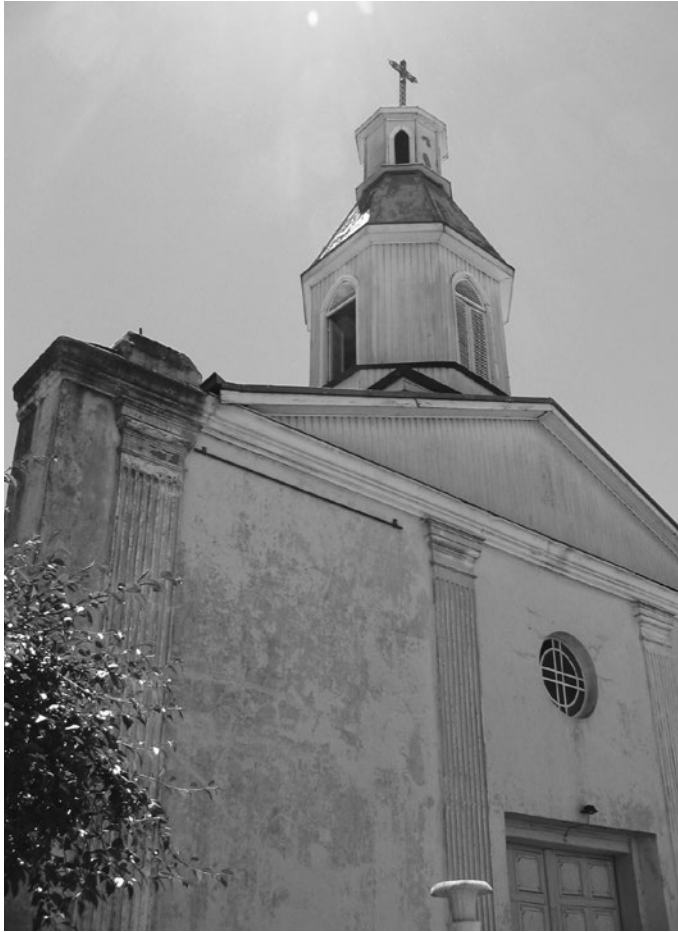
Fig. 201: Convento Franciscano San Buena Ventura de Angol, 1863; Región de La Araucanía. Sistemas constructivos en albañilería de ladrillo y madera. Foto: Cristian Rodríguez.
