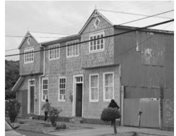
Fig. 33: Fachadas en tejuela de alerce y planchas de fierro galvanizado acanalado en Achao, Chiloé. Foto: GCB.
