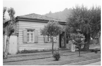
Fig. 2: Vivienda en calle Nahuelbuta esq. Los Canelos, Contulmo. c. 1920. Foto: GCB.
