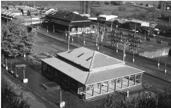
Fig. 138: Barrio Estación en Carahue. 1908. Foto: GCB. (2016)
