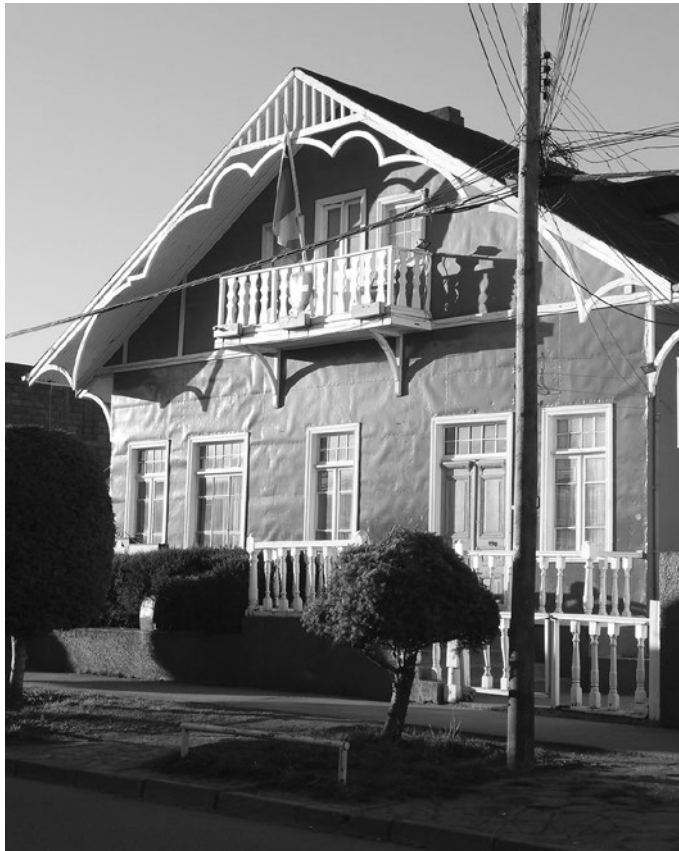
Fig. 217a: Fierro galvanizado liso; vivienda en Punta Arenas. Foto: GCB.
