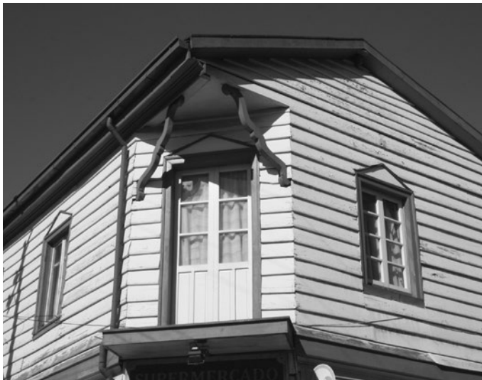
Figs. 61a y b: Almacén de esquina ochavada. Ex Hotel Steiner, calle Imperial 1098, Purén. 1890. Fotos: GCB.
