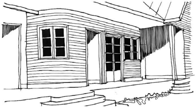
Fig. 137: Estación ferroviaria de Toltén, 1938. El edificio de la estación presenta muros curvos en madera, una de las primeras expresiones de la arquitectura moderna en madera en la zona de La Araucanía. Dibujo: GCB.
