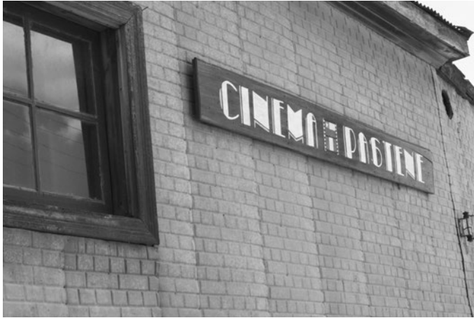
Fig. 131: Cine-Teatro Rex de Capitán Pastene, Región de La Araucanía. 1910. Detalle revestimiento exterior en fierro galvanizado estampado. Foto: GCB.
