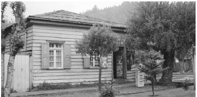
Fig. 16: Vivienda 4 aguas; calle Nahuelbuta esq. Los Canelos, Contulmo. c.1920. Foto: GCB.
