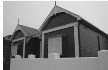
Fig. 41: Vivienda en planchas de latón alisado, Puerto Natales; c. 1920. Foto: GCB.
