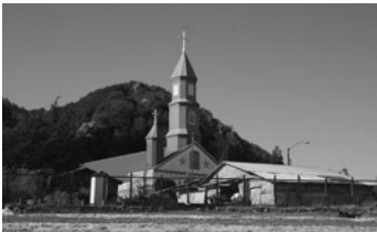
Fig. 37: Iglesia de Tenaún, Chiloé; 1854. Foto: GCB.
