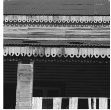
Fig. 141c: Detalle estación ferroviaria de Ranquilco. Región de La Araucanía. 1908. Foto: GCB.
