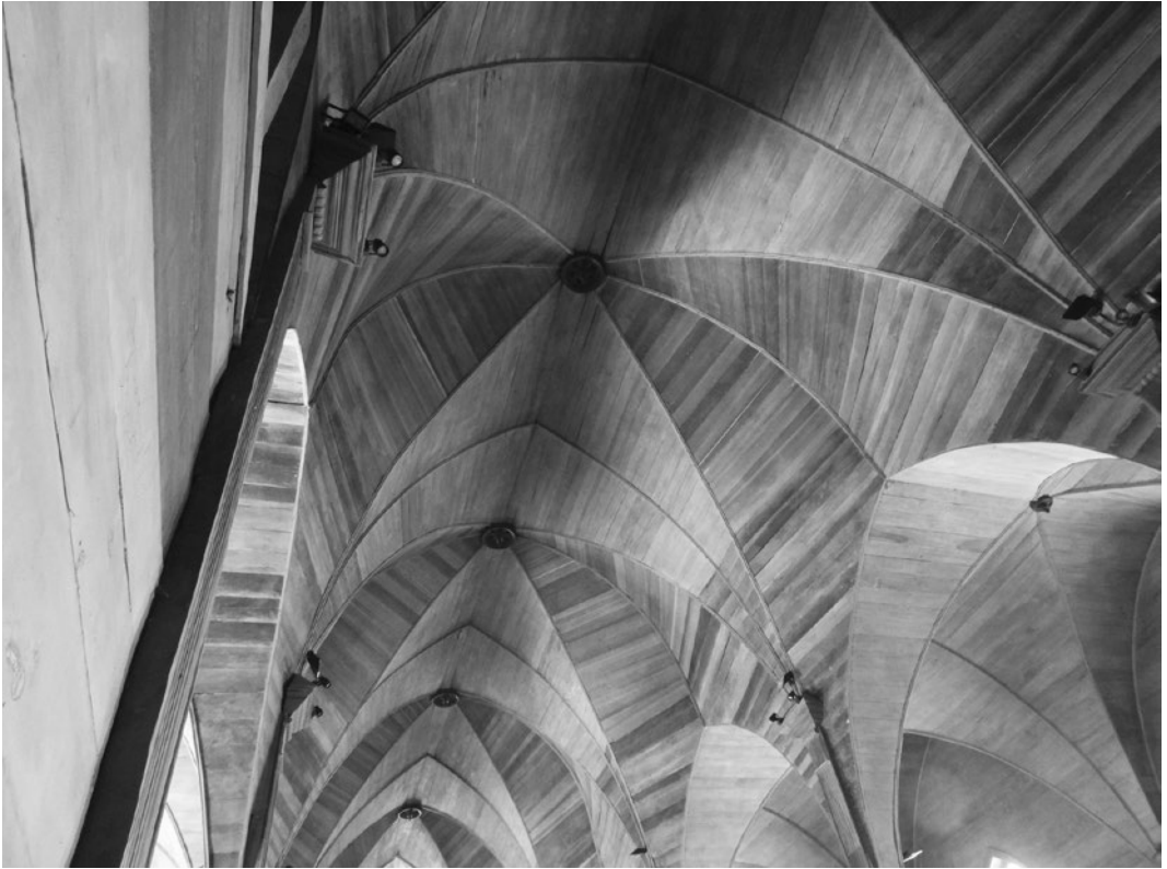
Fig. 209: Entablados traslapados. Bóvedas de crucería Parroquia San Agustín de Puerto Octay. 1911. Foto: GCB.
