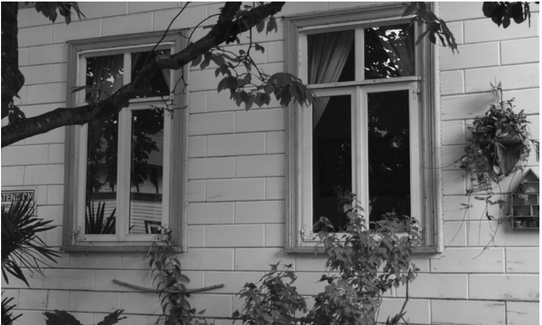
Fig. 210: Entablados machihembrados imitación mampostería de ladrillo. Conjunto Kunstmann. c.1910, Collico, Valdivia. Foto: GCB.
