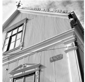
Fig. 20: Revestimientos en planchas de fierro galvanizado, Valdivia. Foto: Mariana Matthews.
