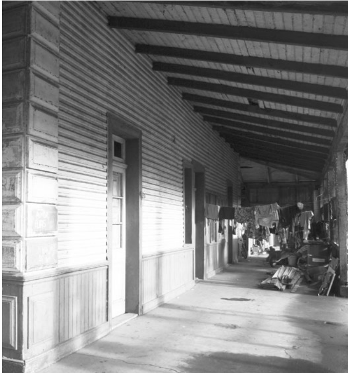
Fig. 141b: Estación ferroviaria de Ranquilco. Región de La Araucanía. 1908. Foto: GCB.
