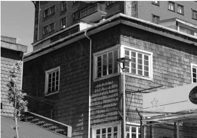
Figs. 80a y b: Soberado con doble techo; calle San Pedro esq. Del Salvador, Puerto Varas, c.1930. Fotos: GCB.
