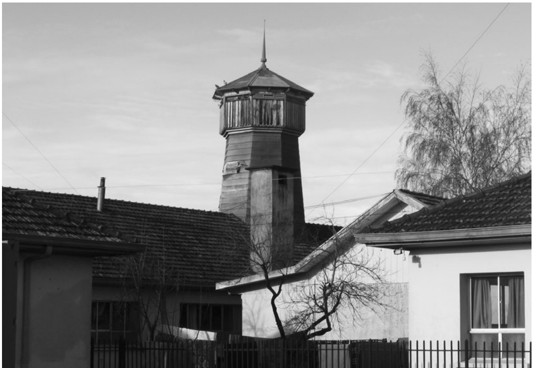
Fig. 111: Estanque de agua en el hospital de Collipulli; Bulnes 50, Collipulli. c.1940. Foto: GCB.
