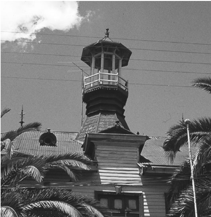
Figs. 115a y b: Edificio Municipalidad de Collipulli, Región de La Araucanía. Calle Alcazar esq. Bulnes, Collipulli. 1919. Fotos: GCB.
