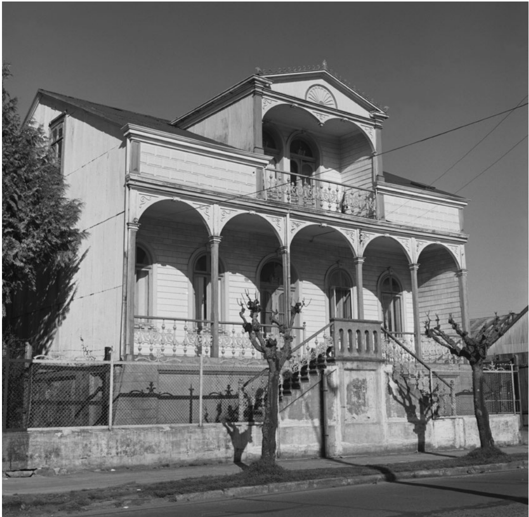
Fig. 75a: Escala de doble entrada y balastradas de hierro fundido; calle General Lagos 1103, Valdivia. c.1900. Foto: Mariana Matthews.
