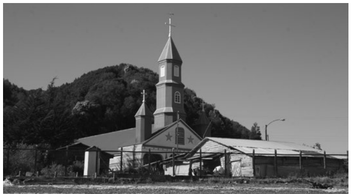
Fig. 167: Iglesia de Tenaun, Comuna de Dalcahue, Chiloe. 1854 (MN). Foto: GCB.
