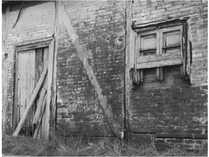
Fig. 204: Sistema constructivo de entramados de madera relleno con ladrillos. Vivienda en Purranque. Foto: GCB.
