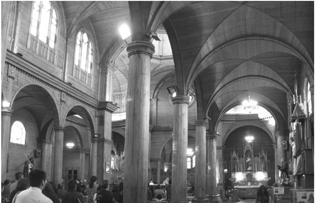
Fig. 220a: Revestimientos interiores en madera. Iglesia San Francisco de Castro, Chiloé. Foto: GCB.
