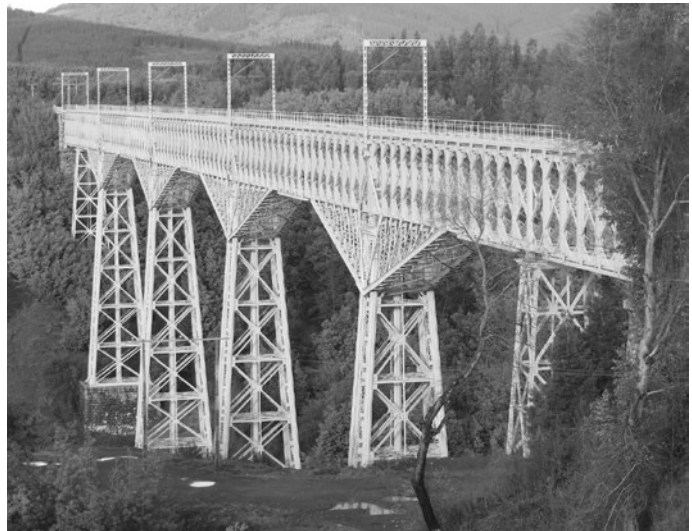
Fig. 132: Viaducto del Malleco, 1890, Collipulli. Foto: GCB.
