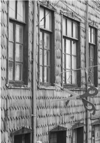
Fig. 213c: Tejuelas de alerce; detalle vivienda en Chonchi, Chiloé. Foto: GCB.
