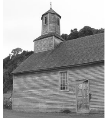
Fig. 165b: Torre iglesia de Detif, Isla Lemuy, Chiloe. c.1910 (MN). Foto: GCB.
