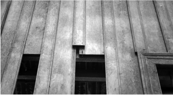
Fig. 211: Entablados de tope con cubrejunta. Bodega ferroviaria de Carahue. 1907. Foto: GCB.
