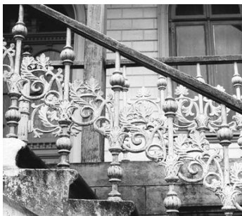
Fig. 75b: Escala de doble entrada y balastradas de hierro fundido; calle General Lagos 1103, Valdivia. c.1900. Foto: Mariana Matthews.
