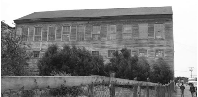
Fig. 227: Ventanas de guillotina; vivienda en Chonchi. Foto: GCB.
