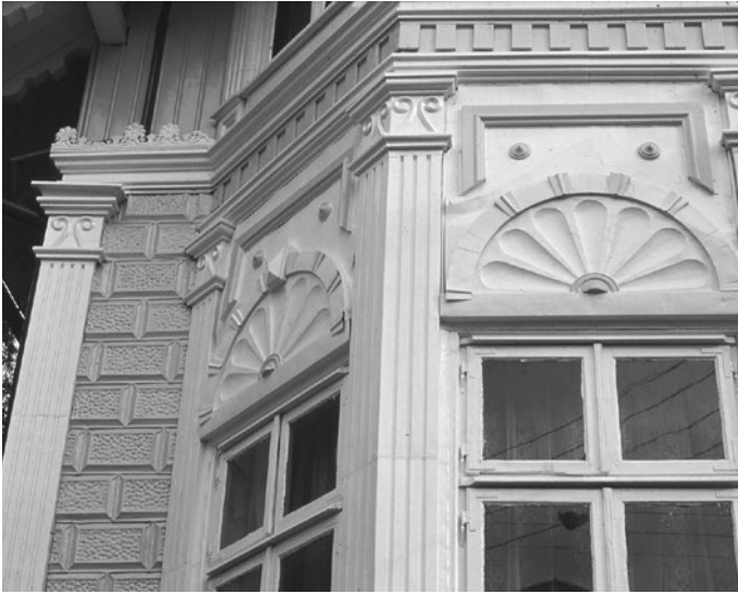
Fig. 218b: Ornamentos metálicos y planchas metálicas estampadas; vivienda en Valdivia. Foto: GCB.
