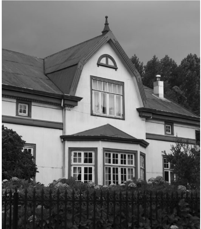
Fig. 215a: Revestimiento en planchas de fierro galvanizado. Vivienda en Collico, Valdivia. Foto: GCB.
