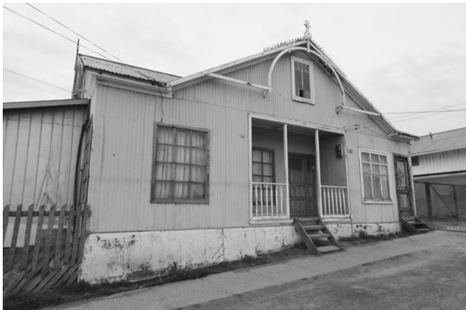
Figs. 91a y b: Pórtico de acceso en calle Croacia 162, Porvenir. c.1920. Fotos: GCB.
