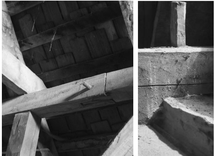
Figs. 205a y b: Tarugos de madera. Fotos: GCB.
