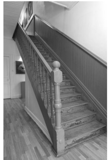
Fig. 11: Escala interior; Avda. Cristóbal Colón 1030, Punta Arenas. c.1920. Foto: GCB.
