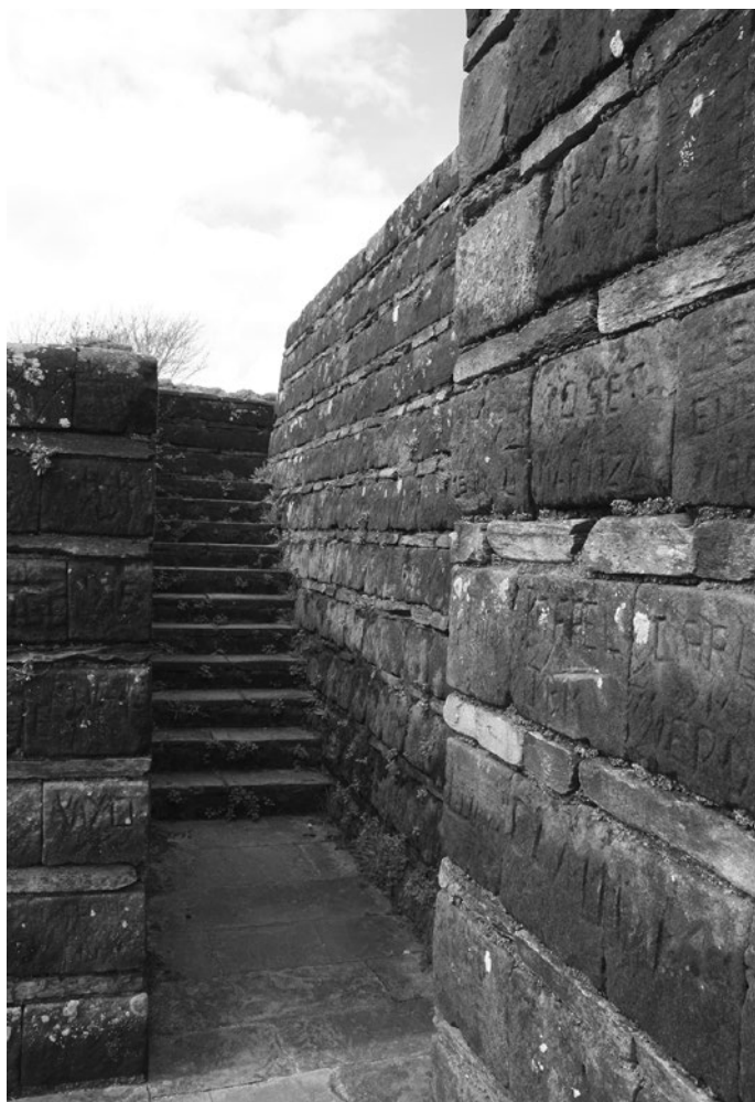
Figs. 203a y b: Castillo San Pedro de Alcántara en la isla Mancera, provincia de Valdivia, Región de los Ríos. Muros de piedra canchagua y piedra laja. Fotos: GCB.
