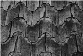
Fig. 213b: Tejuelas de alerce; detalle vivienda en Achao, Chiloé. Foto: GCB.
