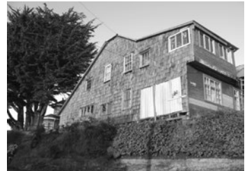
Fig. 34: Fachadas en tejuela de alerce y planchas de fierro galvanizado acanalado en Achao, Chiloé. Foto: GCB.
