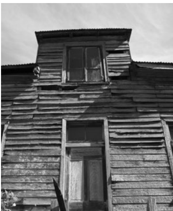
Figs. 208a y b: Entablados tinglados. Viviendas en isla Mancera. c.1920, provincia de Valdivia. Fotos: GCB.
